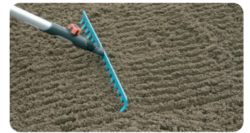
Mit der Harke die Fläche sauber planieren und dann anwalzen.
