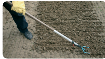
Mit dem Grubber die Fläche lockern und ebnen.
