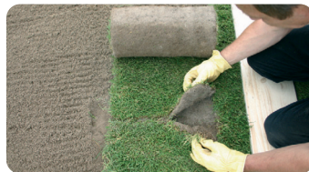
Die Kanten sauber und ohne Spalt verlegen.
